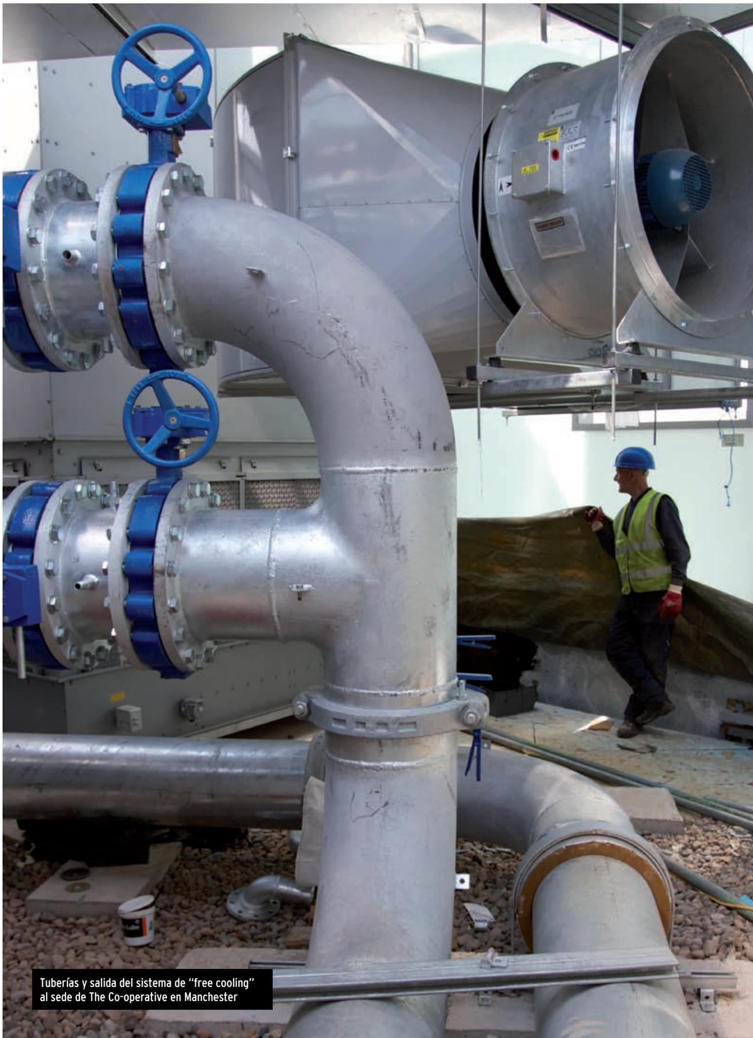
Tuberías y salida del sistema de "free cooling" al sede de The Co-operative en Manchester
